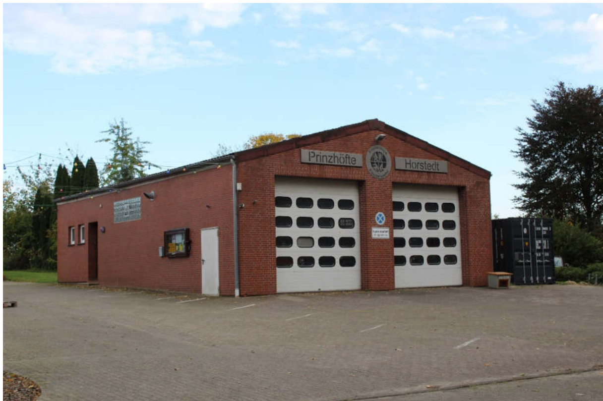
Abbildung 46: Feuerwehrhaus in Horstedt
